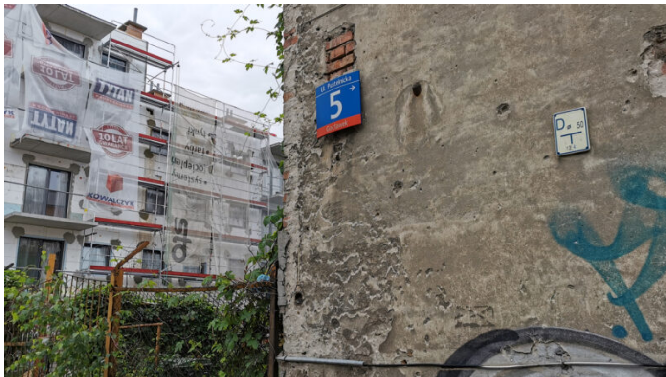
Budowa przy Witolińskiej 43
